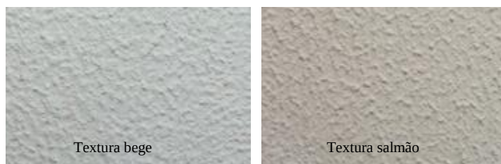
Figura 5 – Superfícies da edificação analisadas em teste do equipamento ALTA II.
